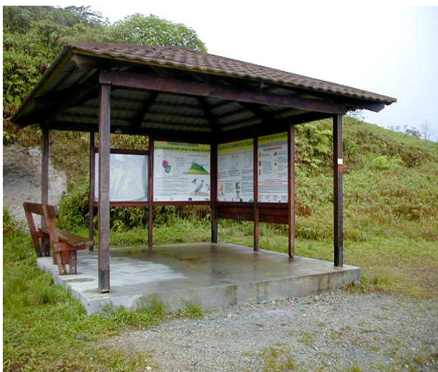
Photo n° 5 – Panneaux sous abri et ajoupa au début du sentier n°38
