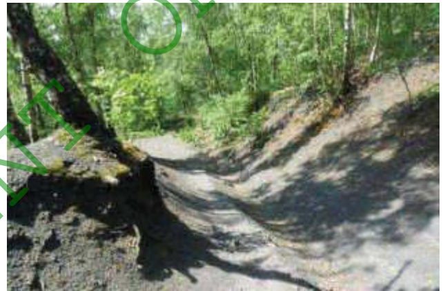
Erosion des sentiers – Terril Sabatier Nord
