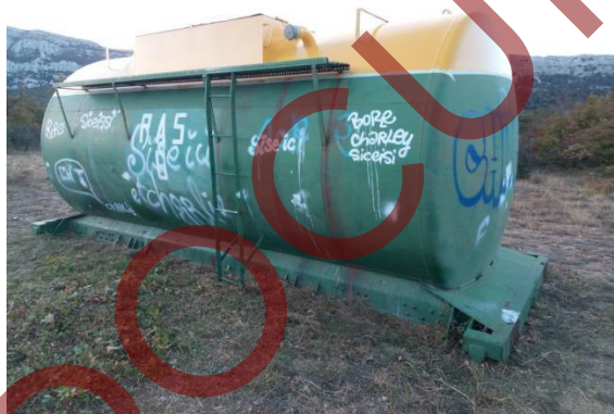
Citerne DFCI HBE 30m3 dégradée
