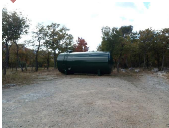
Citerne 30m3 réhabilitée
