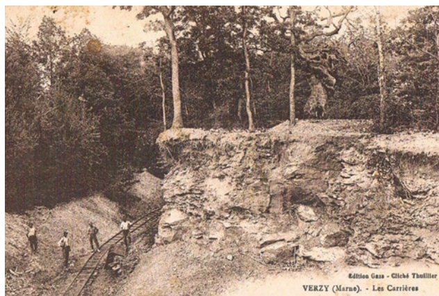
Carte postale ancienne représentant la voie ferrée permettant l'évacuation des meulières sur des wagonnets, aux abords du peuplement de Faux de Verzy © ABREU, 2008
