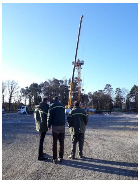
En décembre, le directeur général de l'ONF s'est rendu sur le chantier.
