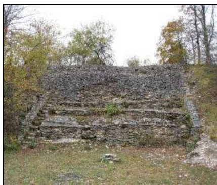
Figure 50 : L'enceinte du châtelet d'Étaules
