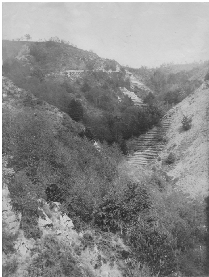
« A gauche (rive droite du ravin) sol granitique. Au dernier plan excoriations traitées par fascinages plantés de saules et pins. Au premier plan peuplement d'aunes et hêtres âgés de 18 ans. A droite (rive gauche du ravin) pentes de pierrailles calcaires, fascinages faits en 1882. »
