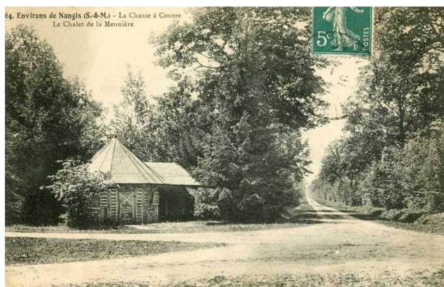
Figure 212 : carte postale ancienne illustrant le chalet de la Meunière, le dernier des trois chalets forestiers construits du temps de l'inspecteur de la Rue, au carrefour du même nom en forêt domaniale de Villefermoy.
