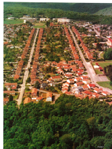
Figure 134 : ci-dessus, la cité ouvrière de Froidcul (vue aérienne).
