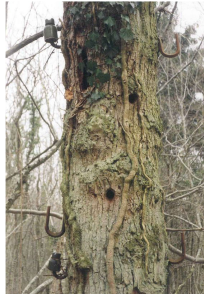
Figure 100 : chêne « poteau électrique » en forêt communale de Saint-Baussant (54)
