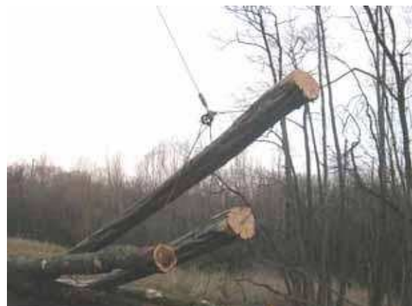
Débardage par câble
