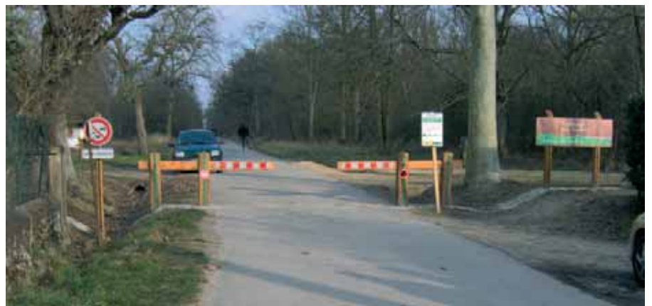
Entrée avec barrière double
