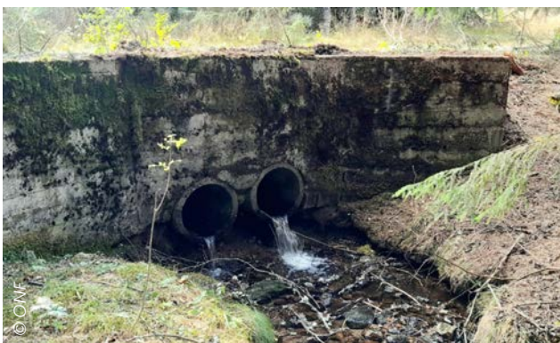
Ouvrage de type deux buses en pierre, remplacé par passage inférieur à portique ouvert.
