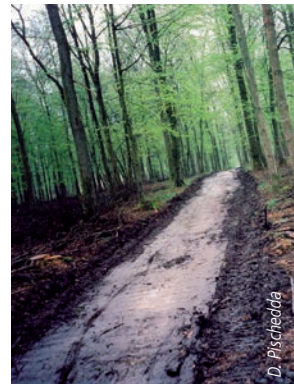
Après « remise en état » : les ornières ont seulement été rebouchées par la lame de l'engin
