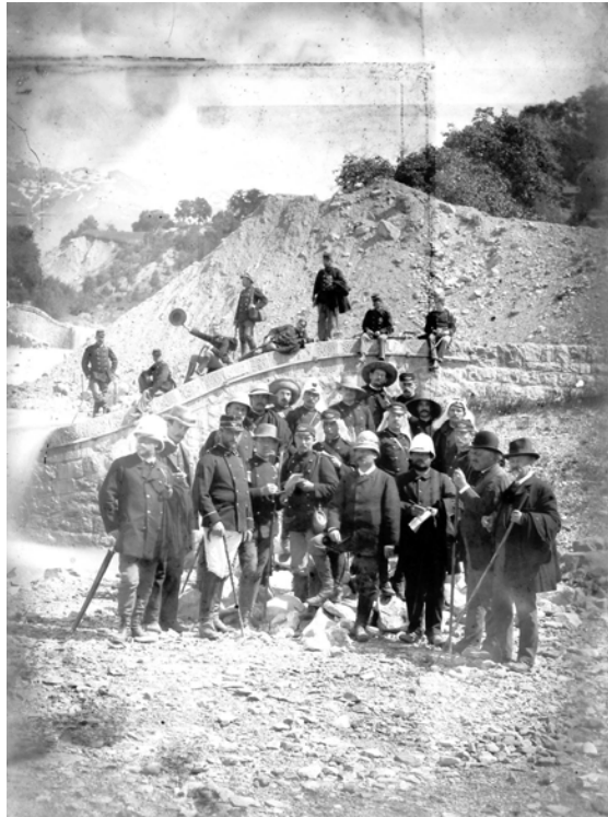
Photo 37 : Torrent des Vachères - Commune de Saint-Sauveur (05).
