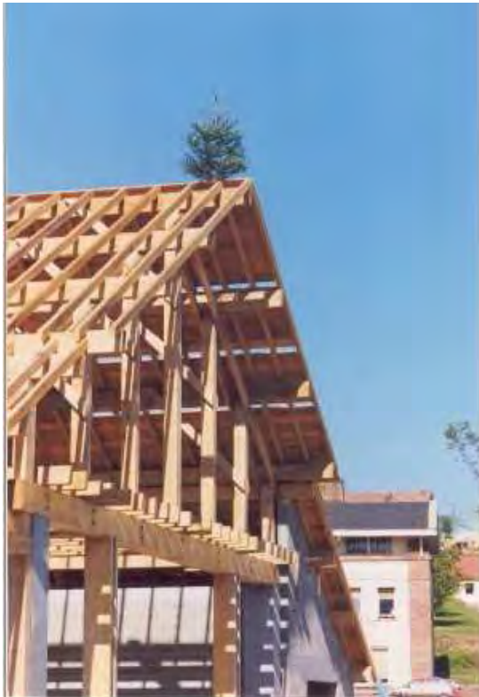
Photo 94 : construction de la charpente en août 1997
